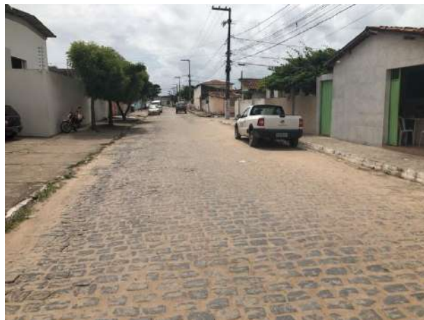
Foto 4 Trecho da Via Santo Antônio.
