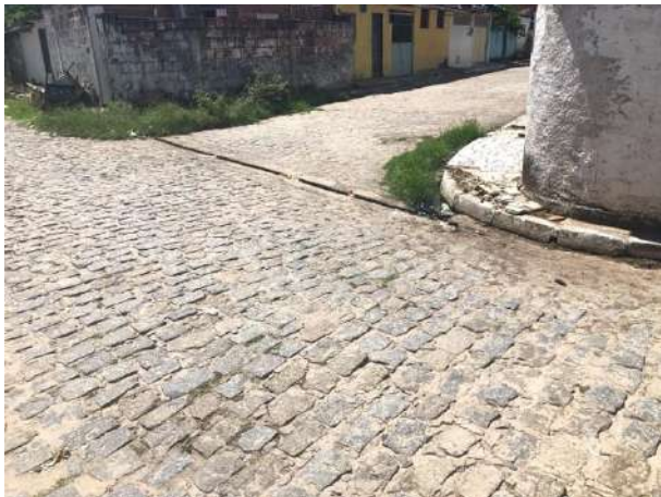
Foto 3 Trecho da Via José Alves da Nóbrega 02
