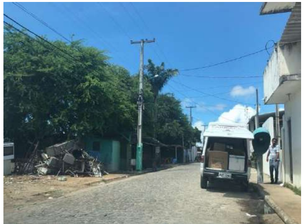
Foto 2 – Trecho da Via Ambrósio Miranda.
