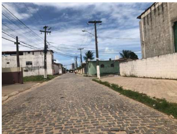
Foto 3 – Rua Raul Seixas – Trecho próximo ao Haras.
