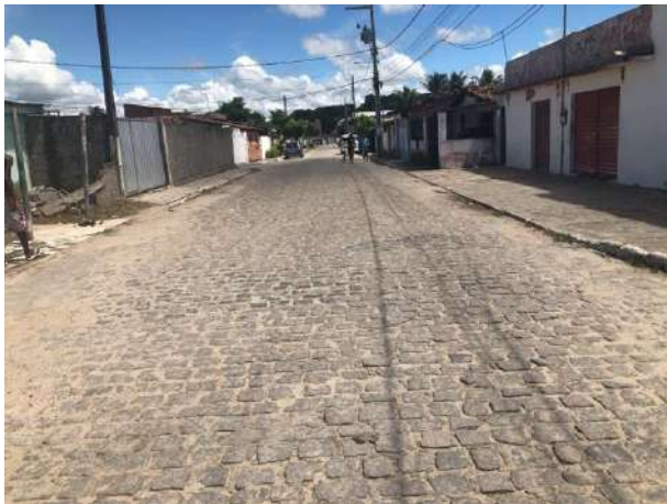
Foto 1 – Trecho da Via Ambrósio Miranda.
