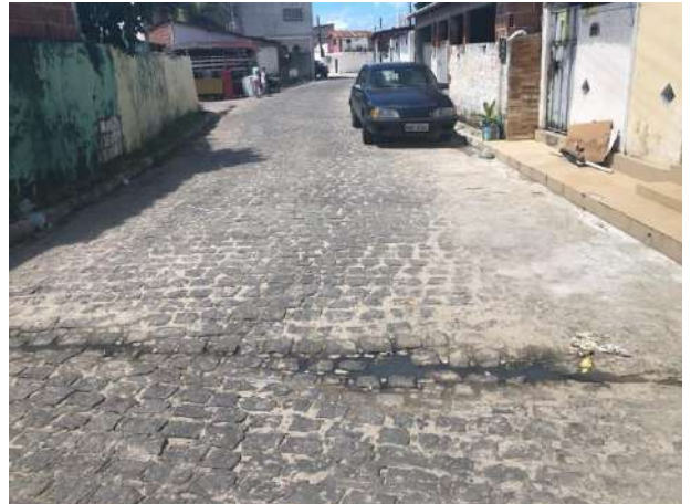
Foto 2 – Trecho da Via N S Conceição
