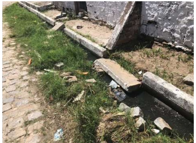
Foto 4 – Trecho da Via José Alves da Nóbrega 01.
