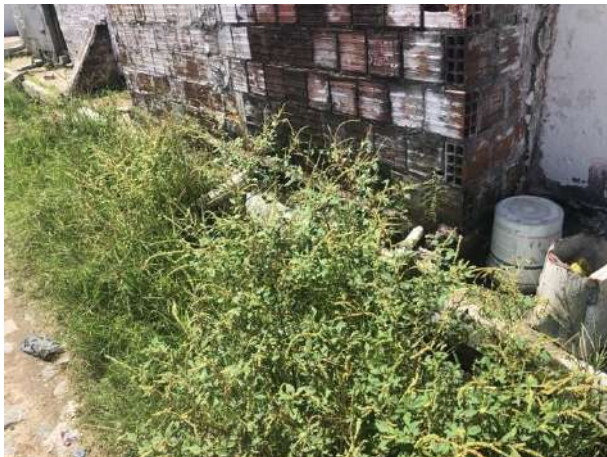
Foto 3 – Trecho da Via José Alves da Nóbrega 01.
