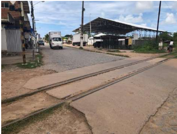
Foto 5 – Trecho final Rua Raul Seixas – linha Férrea.
