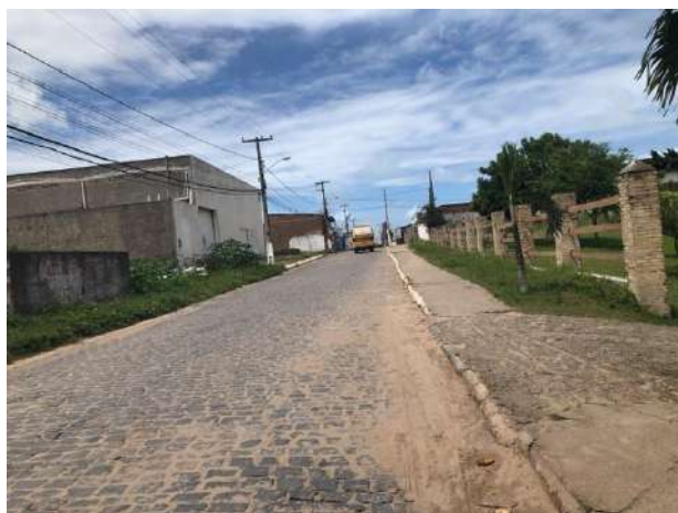
Foto 4 – Rua Raul Seixas – Trecho próximo ao Haras.
