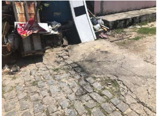
Foto 2 – Trecho da Via José Alves da Nóbrega 01.
