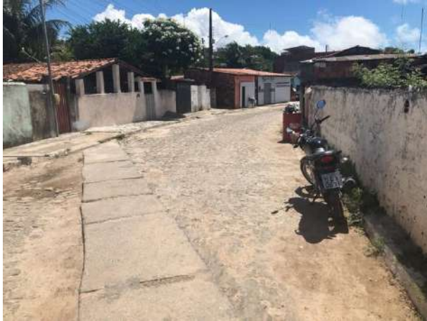
Foto 1 – Trecho da Via José Alves da Nóbrega 02
