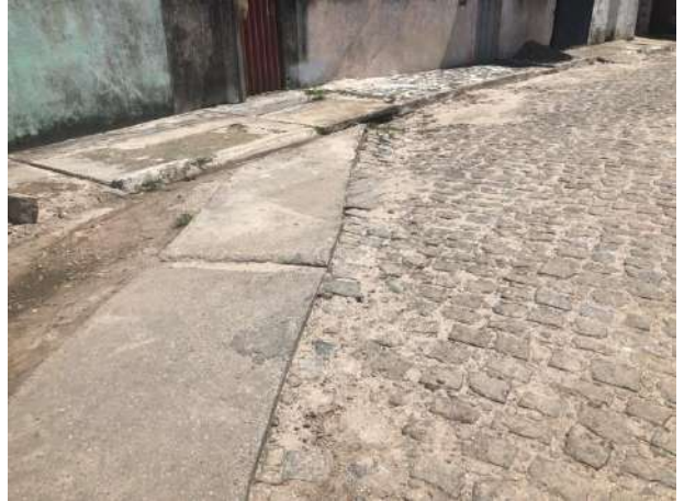
Foto 2 Trecho da Via José Alves da Nóbrega 02
