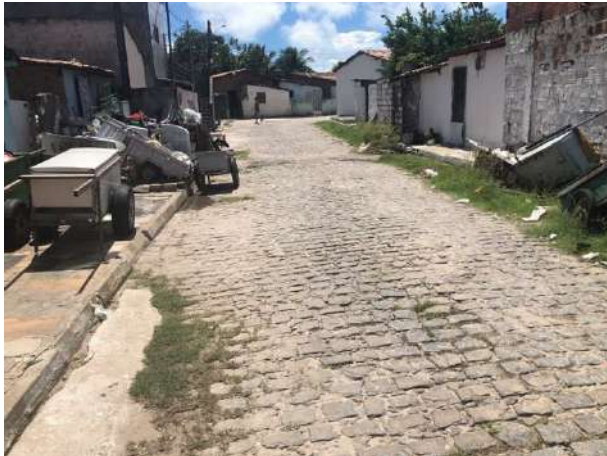
Foto 1 – Trecho da Via José Alves da Nóbrega 01.
