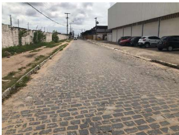
Foto 2 - Trecho próximo a Projecta Início da Via.
