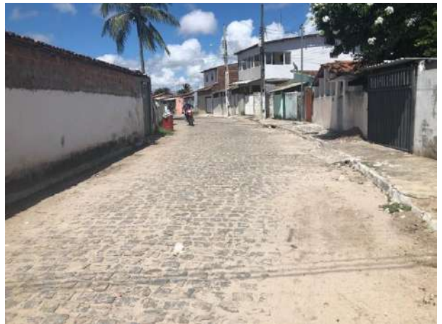
Foto 4 Trecho da Via José Alves da Nóbrega 02
