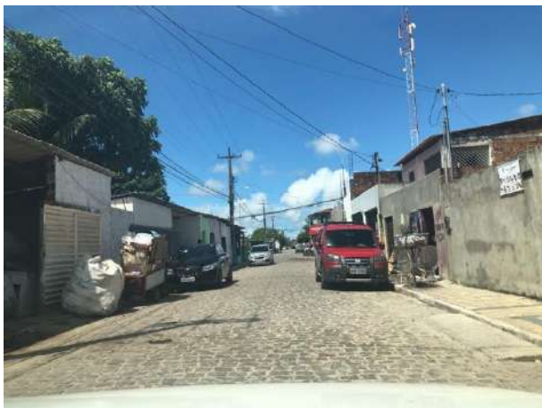
Foto 3 – Trecho da Via Ambrósio Miranda.
