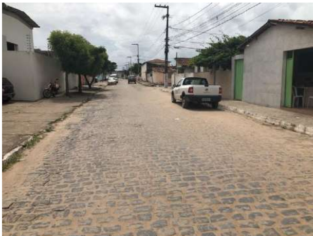
Foto 1 – Trecho da Via Santo Antônio.
