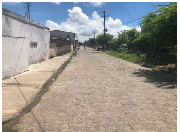
Foto 6 – Trecho da Via Ambrósio Miranda.
